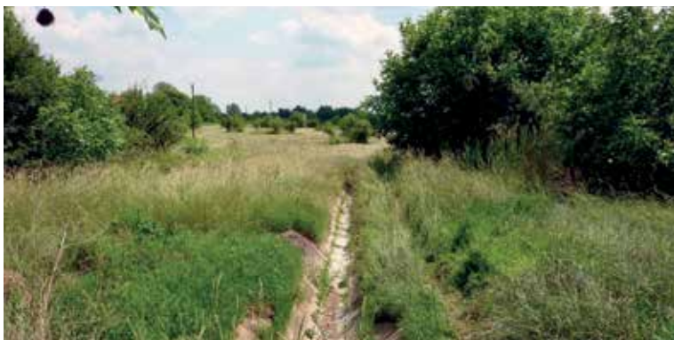
A területet kettészelő, tiszta csapadékvíz elvezető meder
