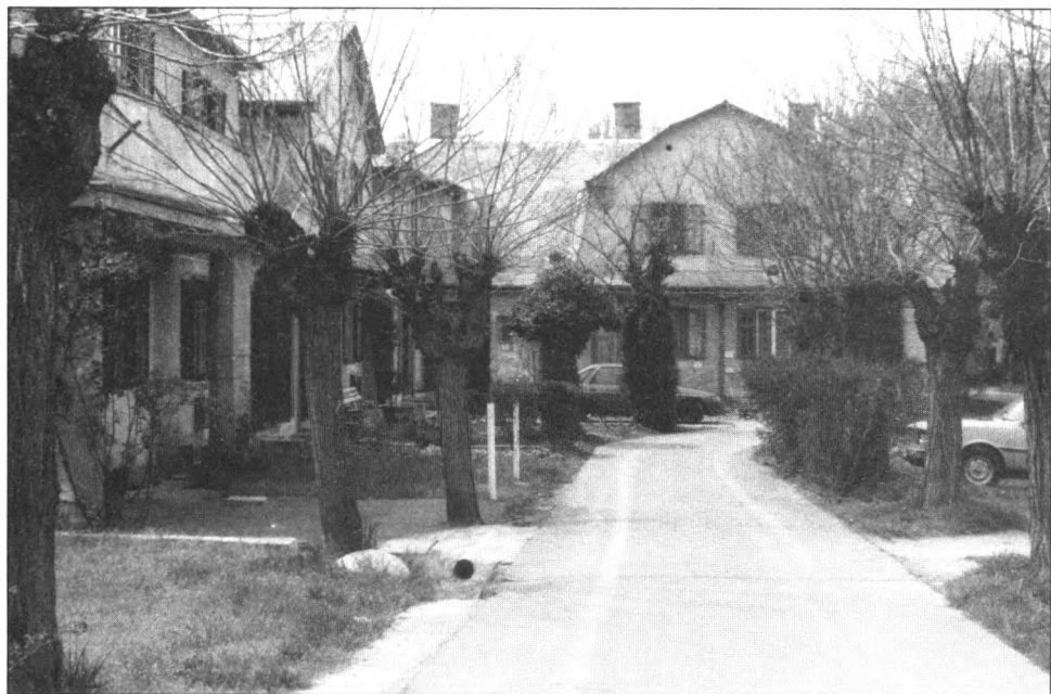
4. A korai szuburbanizáció előőrsei voltak az állam, az önkormányzatok s a (többnyire állami kézben lévő) nagyvállalatok "telepei", a mai külső kerületekben s a főváros mai közigazgatási határain túl is; Dunakeszi, MÁV kolónia.
